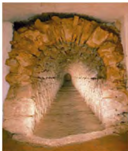
Conduite d'aigües de Badalona
